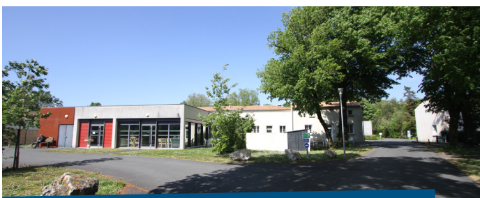
LE CENTRE DE SOINS DE SUITE DU CHÂTEAU DE MARLONGES
